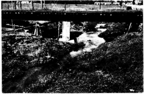
Alcantarilla del ferrocarril sobre el arroyo Mordazo, única vía útil, pero insuficiente, por donde se realiza el drenaje de la Ciénaga.
